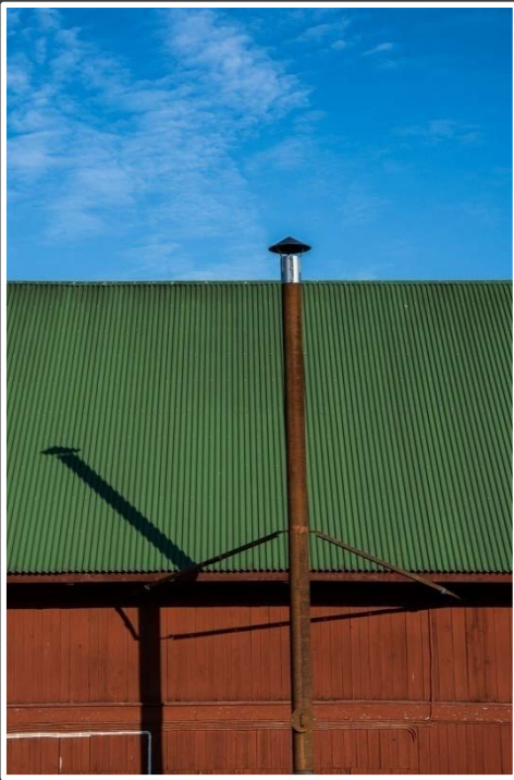
Dies & Das: Abluft Scheune - Allmunge, Schweden
